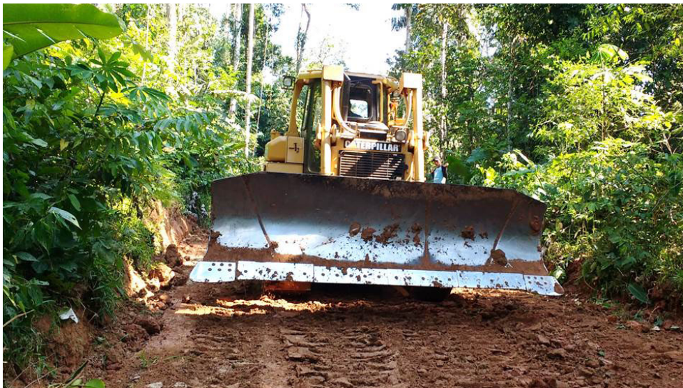
Figura 10. Construcción de caminos (Tomado de http://www.inforegion.pe )
