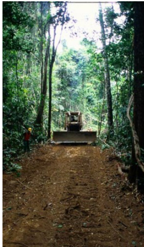
Figura 8. Construcción de caminos forestales (Tomado de http://laguayanaesequiba.blogspot.com )
